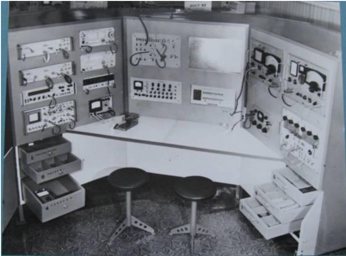
ОБЩИЙ ВИД ПОСТА ДЛЯ ПРОВЕДЕНИЯ РЕМОНТА И РЕГЛАМЕНТНЫХ РАБОТ НА СРЕДСТВАХ СВЯЗИ
