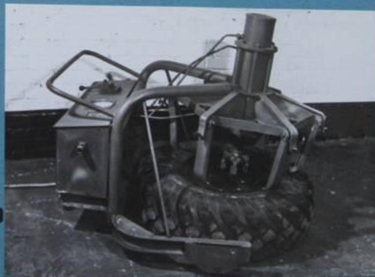
Пост разбортировки автомобильных покрышек
